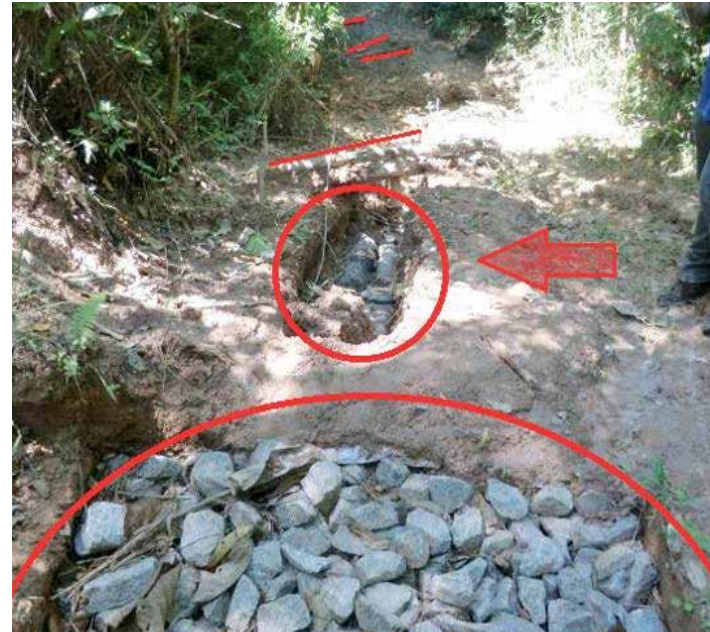
▶ FIGURA 1-12 Exemplo de sulco existente no interior da REBio Tamboré, com medidas de contenção de erosão e resultados satisfatórios.
